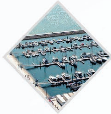
Obras marítimas, proteção costeira e marinas
